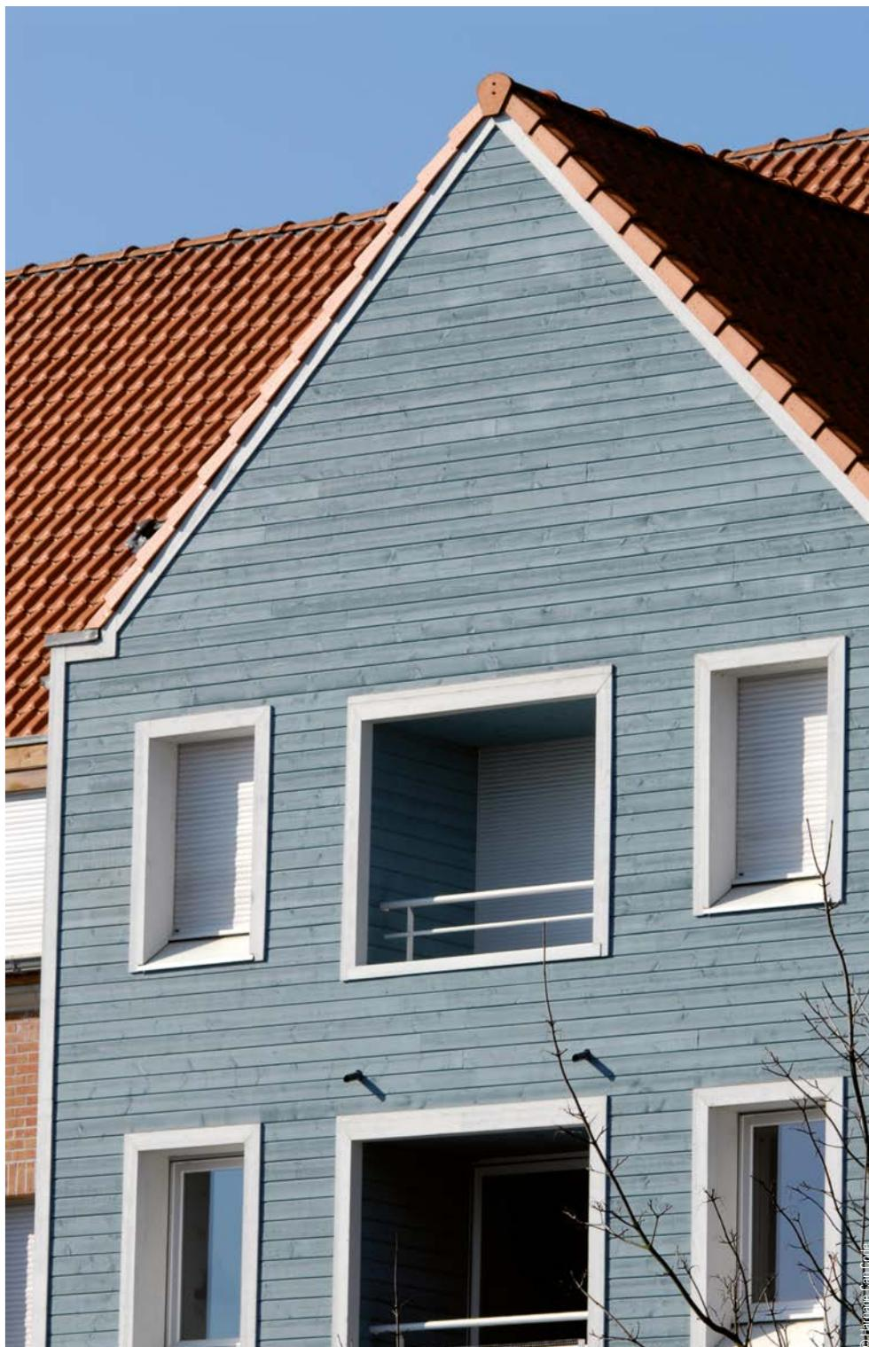
bois. Pour une utilisation en façade, un bois devra au minimum atteindre un niveau de classe d'emploi 3, soit naturellement, soit après un traitement spécifique. Dans certains cas, le bois classe 2 est utilisé pour un bardage abrité et non exposé aux intempéries. Sur une façade très exposée aux vents dominants, seule une essence classe d'emploi 3-2, exempte d'aubier, correspondant à une humidification très fréquente sur des périodes de plusieurs
