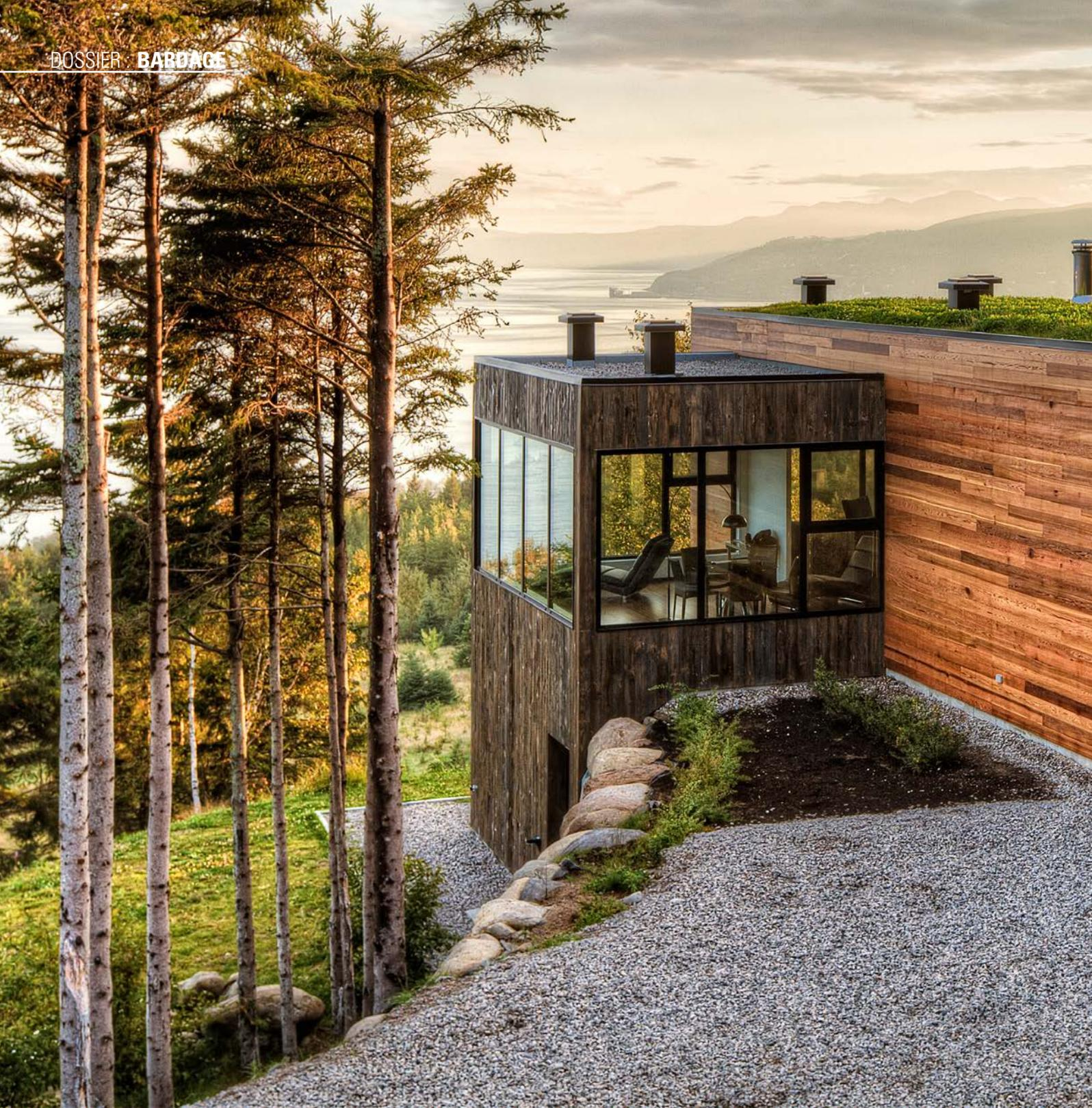
*lames de bardage ne peuvent pas être modifiées, recoupées, rainurées sans être fragilisées. C'est d'ailleurs le cas de tous les Pins traités classe d'emploi 4. Les lames peuvent être recoupées dans le sens de la longueur, mais il faut appliquer un traitement à base de cire sur le champ de coupe afin de l'imperméabiliser ».*
